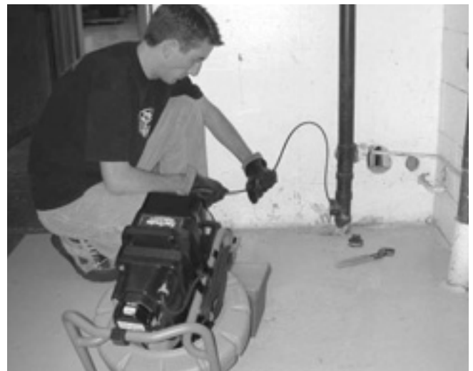
Figure 16 – Manière incorrecte de tenir le câble d'avancement
